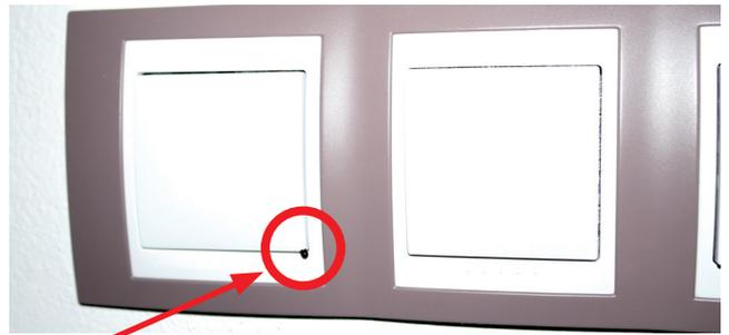
čidlo umístěné v rohu slepého vypínače se zachováním designu vypínačů v objektu
